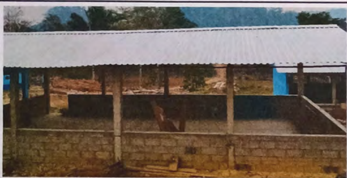
Foto 3: fase final de mantenimiento, techado, fundición de piso y levantado de pared de media altura del modulo III.
